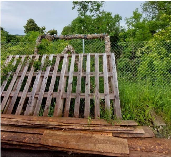
Was bewegt einen, eine Palette etc. und sonstigen Unrat in eine Zaunanlage zu werfen? Der Spanndraht ist gerissen und der Zaun beschädigt: Kostenträger dieser Instandsetzungsmaßnahme ist der Gebühren-zahler Abwasser.
