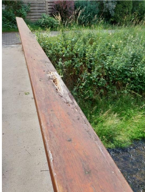
Handlauf durchgefault
