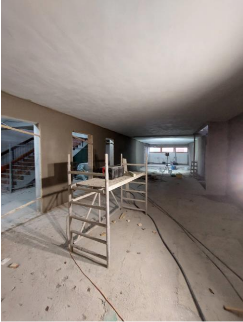
Bild von den sanierten Umkleideräumen
