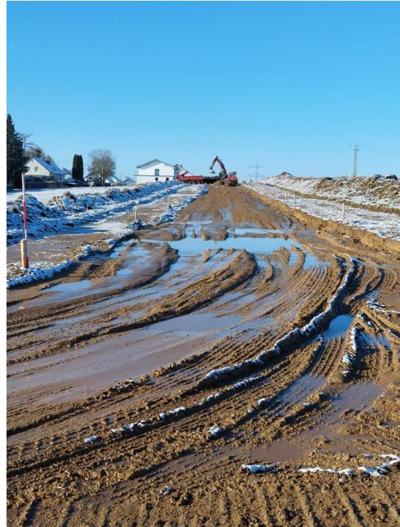
Bild: Oberboden abgeschoben
