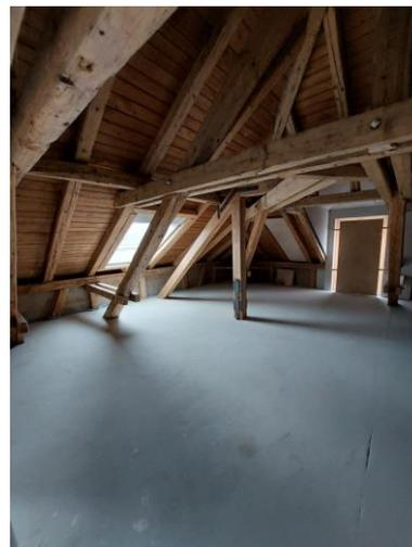
Unterm Dach / Multifunktionsraumraum / Sichtbarer Dachstuhl / Das Gebälk wurde mit Trockeneis gestrahlt.
