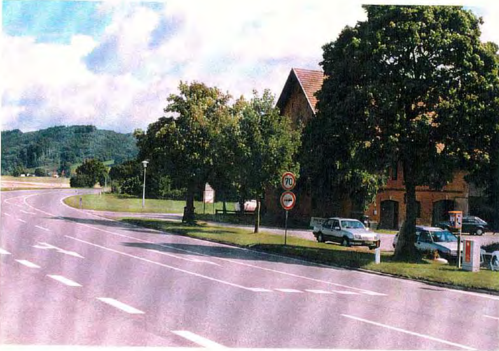
Foto 1: Nordwestlicher Ortsrand von Oberessendorf
